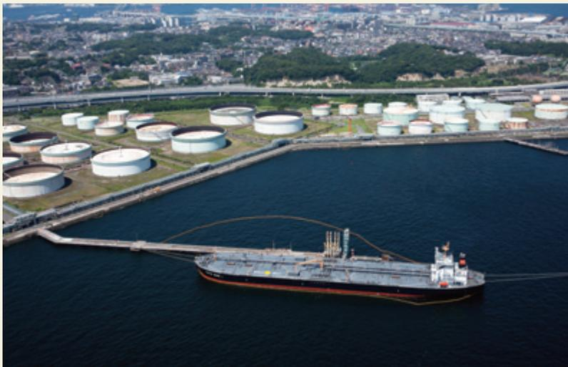
産油国から日本に到着したタンカーは、製油所のシーバース(棧橋)に係留されます。タンカー内の原油は海底のパイプラインを経由して製油所敷地内の地上タンクに荷揚げされます。
